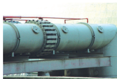
可拆伸缩节结构
