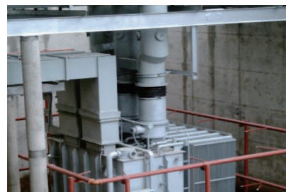
厂变连接结构
